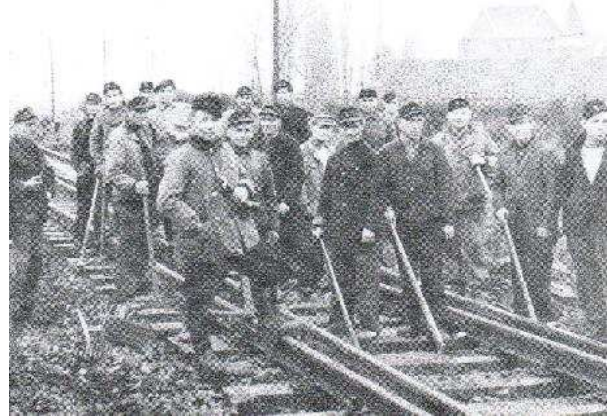
Rottenarbeiter bei Gleisarbeiten in Eschweiler-Röthgen, 1951 Foto: Lanzen, E.-Röthgen
