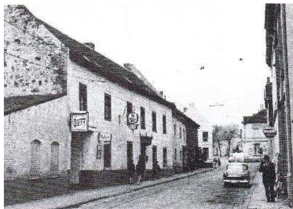
Eschweiler, Kochsgasse, 1965, Foto: Eberhard Becker
